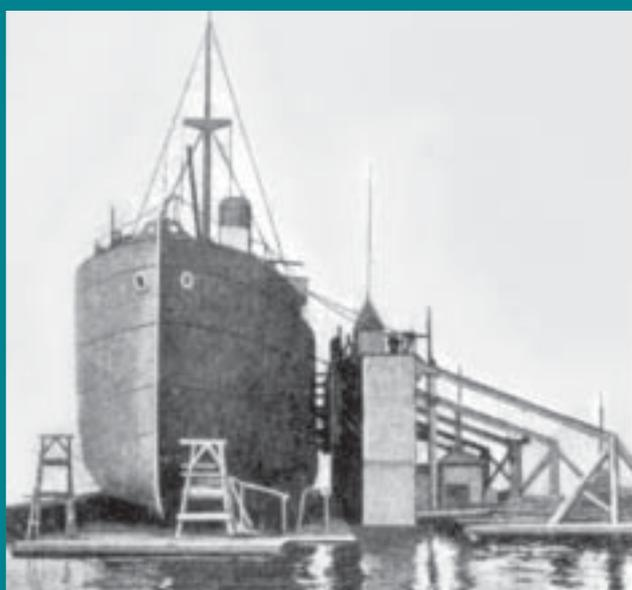
Рис.4. Однобашенный плавучий док
