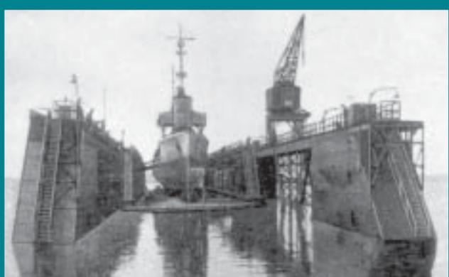
Рис.5. Вывод судна, стоящего на док-понтоне, из док-матки
