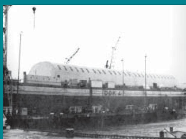
Рис.6. Плавучий док с закрытием внутридокового пространства от осадков
