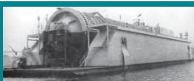
Рис.14. Плавучий док-камера для испытания корпусов подводных лодок давлением
