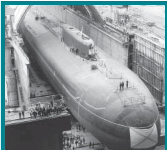
Рис.12. Завершающий этап продольной накатки подводной лодки на передаточный плавучий док
