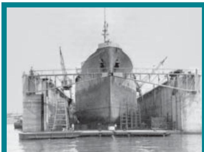
Рис.2. Двухбашенный плавучий док
