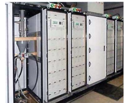
*Автоматизированная радиопередающая система большой мощности*
