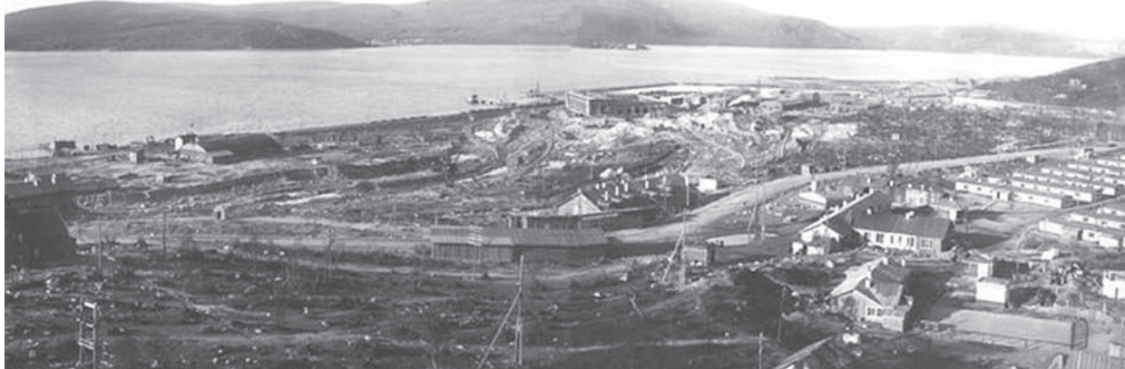
Строительная площадка Мурманского судоремонтного завода, 18 июля 1942 г.
