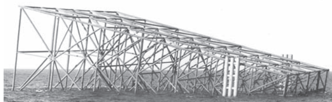
Рис. 2. Опорный блок с плавучей гранью на плаву
