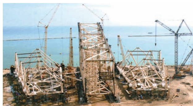
Рис. 8. Формирование опорного блока из панелей
