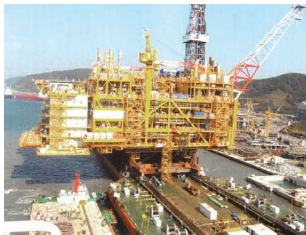
Рис. 4. Отгрузка ВС морской платформы весом 30 000 т на баржу для месторождения SHWE на шельфе Мьянмы
