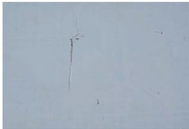
Рис. 13. Трещина шпатлевки в районе стыка стеклоткани
