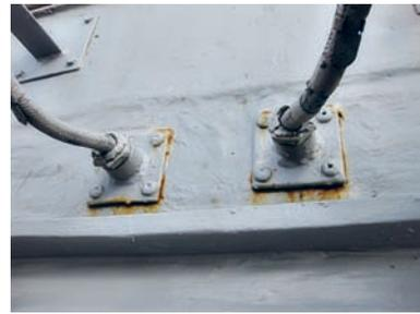
Рис. 16. Коррозия сальников прохода кабеля
