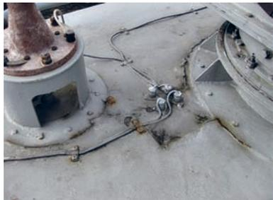
Рис. 15. Коррозия и нарушение герметичности сквозного крепежа
