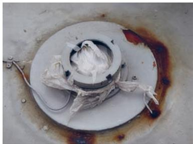
Рис. 14. Коррозия фундамента и крепежа его крепления на открытой палубе
