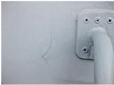
Рис. 11. Трещина шпатлевки в районе наформовки под крепление поручня
