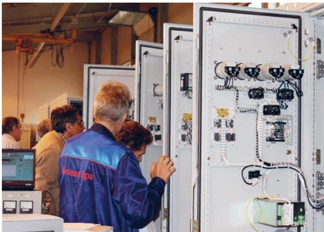
Согласно условиям договора, ОАО «Новая ЭРА» разработала и изготавливает для ПЭБ наиболее важные и сложные щиты: это средневольтные щиты на напряжение 10,5 кВ главные распределительные устройства (ГРУ1,2) напряжением 10,5 кВ ГРУ 1,2, щиты заземления нейтрали главного генератора, щиты выдачи электроэнергии на берег, главные
