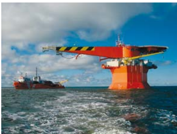
Рис. 2. Загрузочный причал башенного типа на гравитационном основании (GBS)
