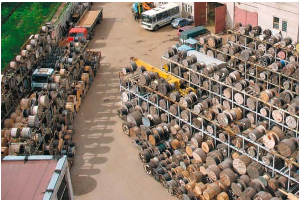
«Кабельное поле» нового комплекса
