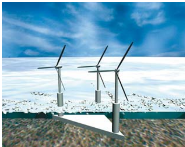
Рис. 1. Железобетонная стационарная ветровая электростанция мощностью 15 МВт
